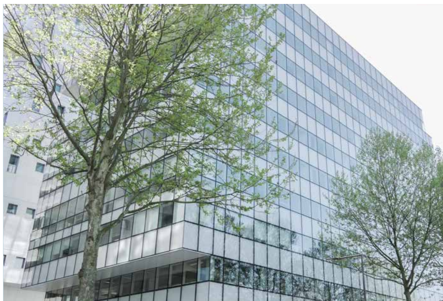
Extérieur du nouveau bâtiment de Strasbourg
